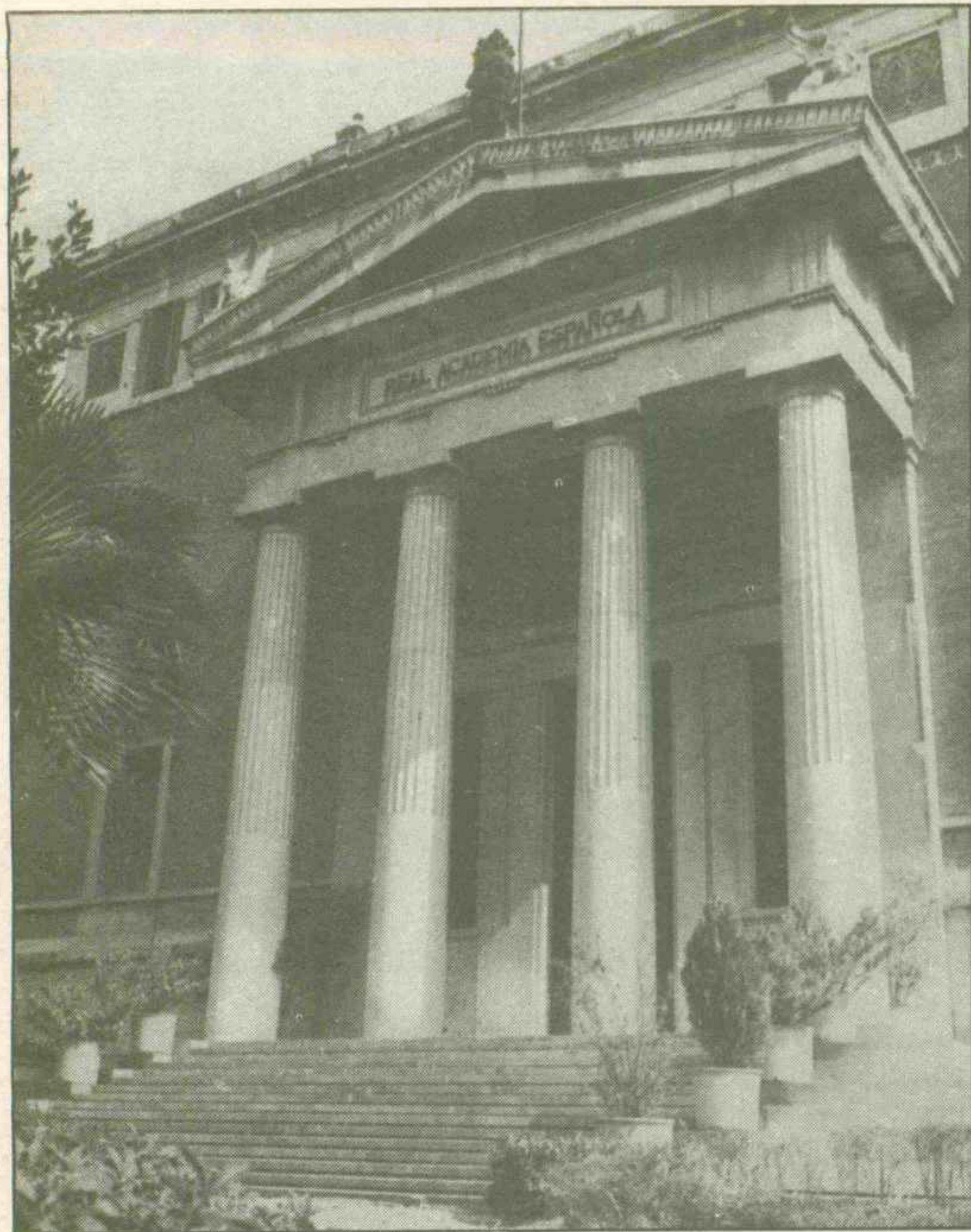
Fachada del edificio de la Real Academia Española de la Lengua, en la madrileña calle de Felipe IV.
