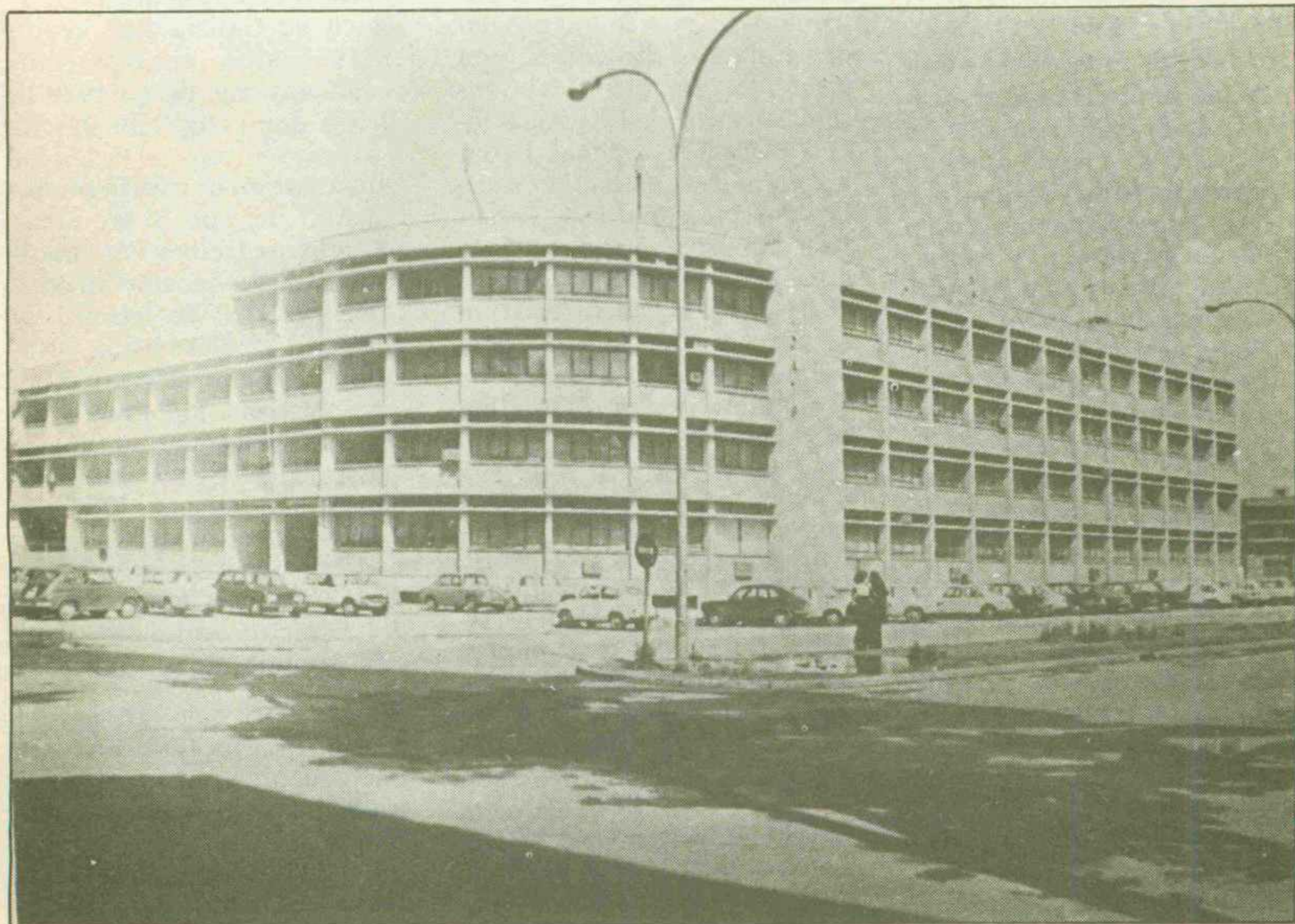
El moderno edificio del Centro de Edafología y Biología Aplicada del Segura e Instituto de Orientación y Asistencia Técnica del Sureste en Murcia. (De un folleto de propaganda de dicho Centro).
