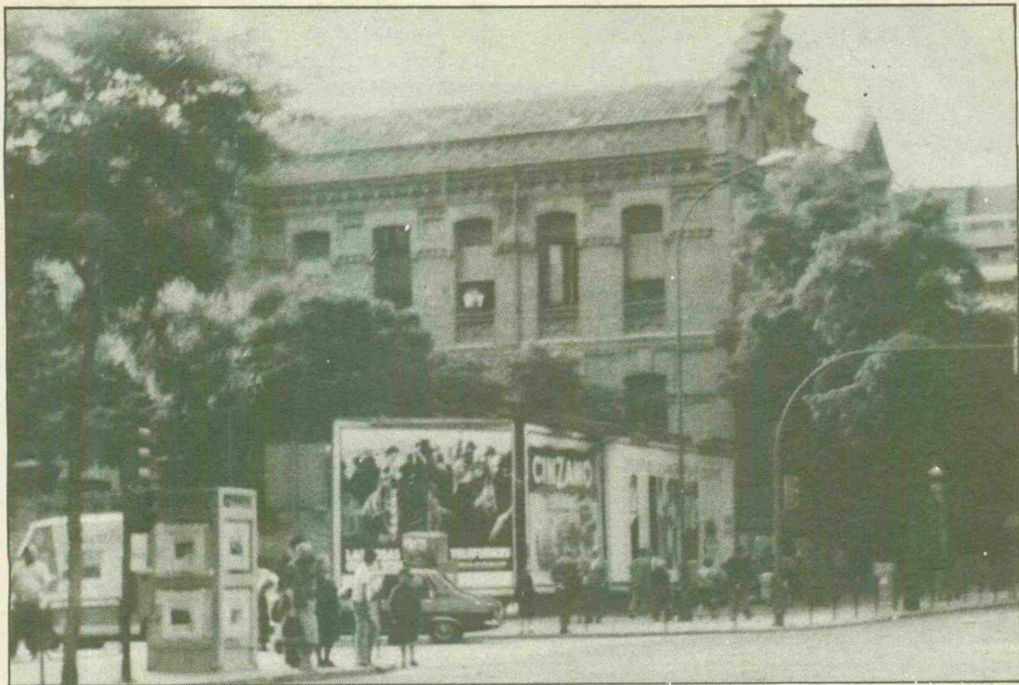
Angulo de la antigua cárcel de Torrijos con la calle de Padilla.
